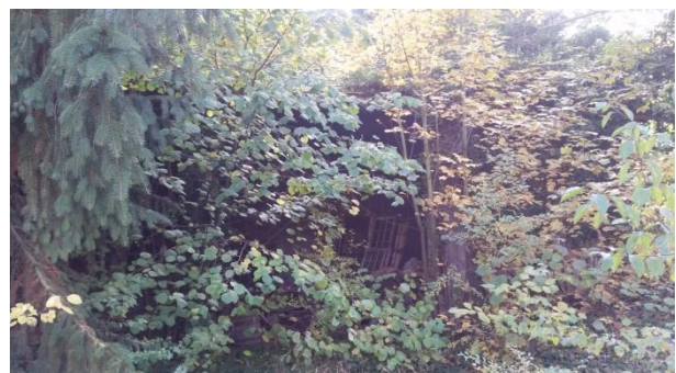
Vue de l'ancienne grange
