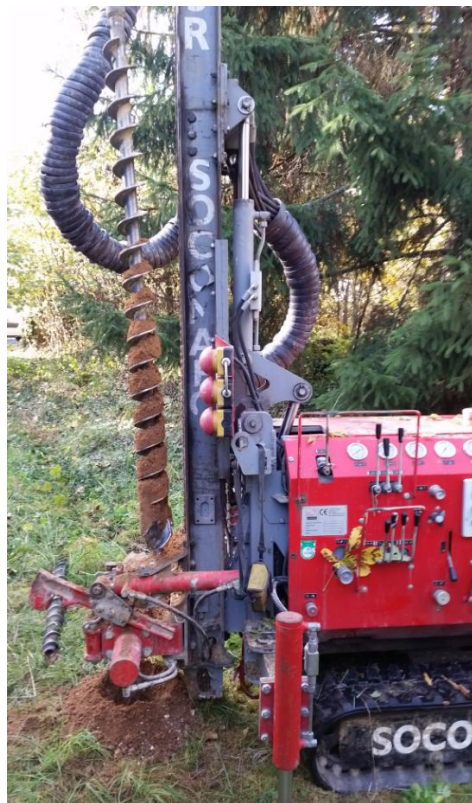
Figure 2 : Réalisation d'un sondage à la tarière mécanique
